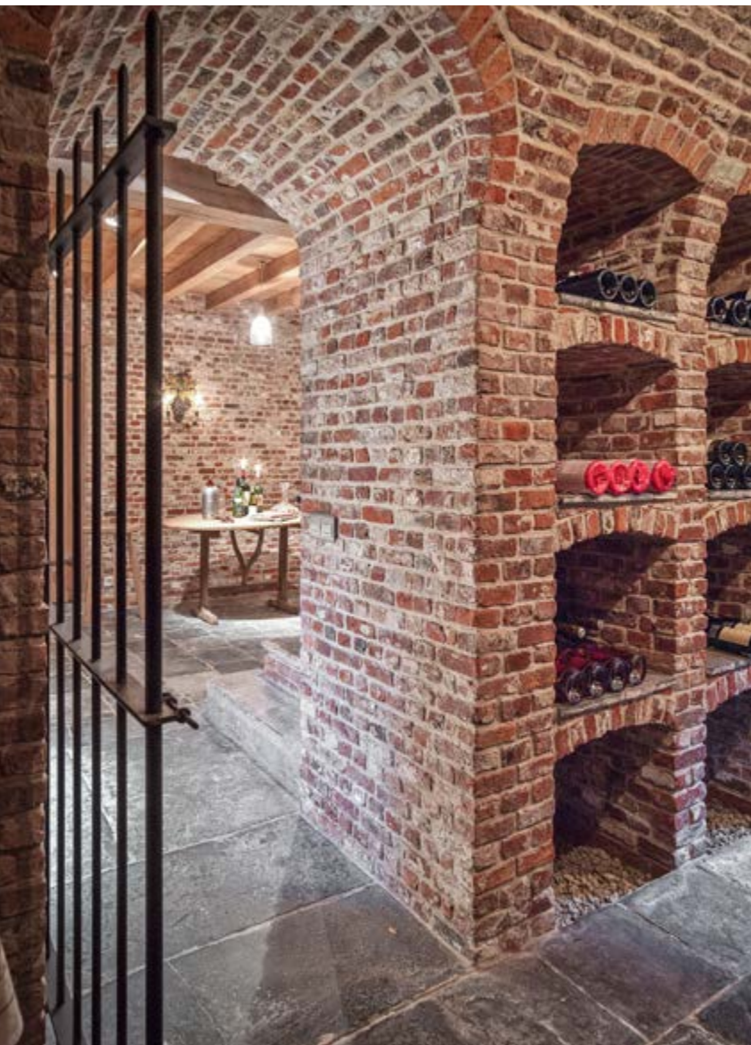
In de wijnkelder zijn gerecupereerde baksteentjes gebruikt en ligt er een vloer van oude 'schorren'.
